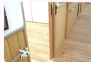
廊下の手摺にも杖置きを設置
